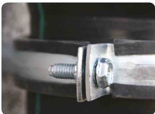
Obr. 7 – Nesprávné utažení
